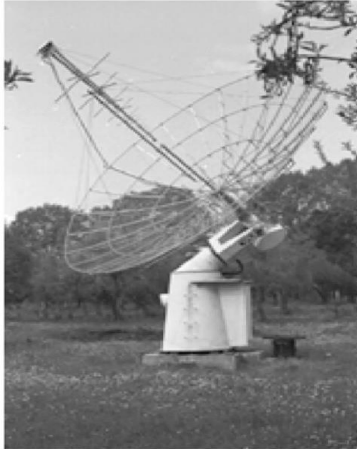
Παραβολική λογαριθμική κεραία διαμέτρου 7m, Τοποθεσία: Δορυφορικός Σταθμός Θερμοπυλών
